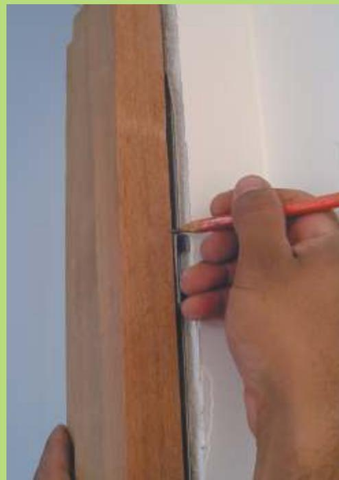
desprendimento desta espuma após secagem, caso ocorra alguma batida mais forte da porta. O sistema de fixação, batizado como Fixus, garante total travamento do batente na parede, pois trilhos metálicos são fixados através de parafusos e também no batente e posteriormente encaixados e ajustados.
